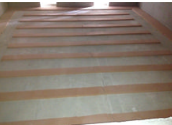
Regufoam als trillingsdemper in de Qubic studio te Hooglanderveen
